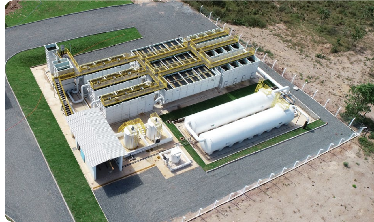
Uruaçu WTP - Saneago Collection
