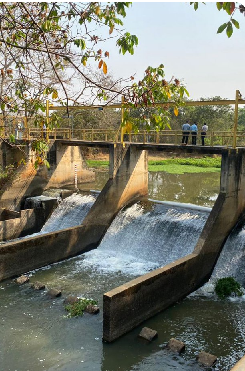
Barragem Rio Meia Ponte/Acervo Saneago
