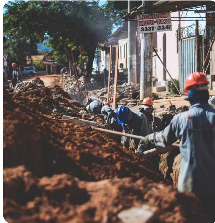
Ampliação do Sistema de Esgotamento Sanitário de Pirenópolis
