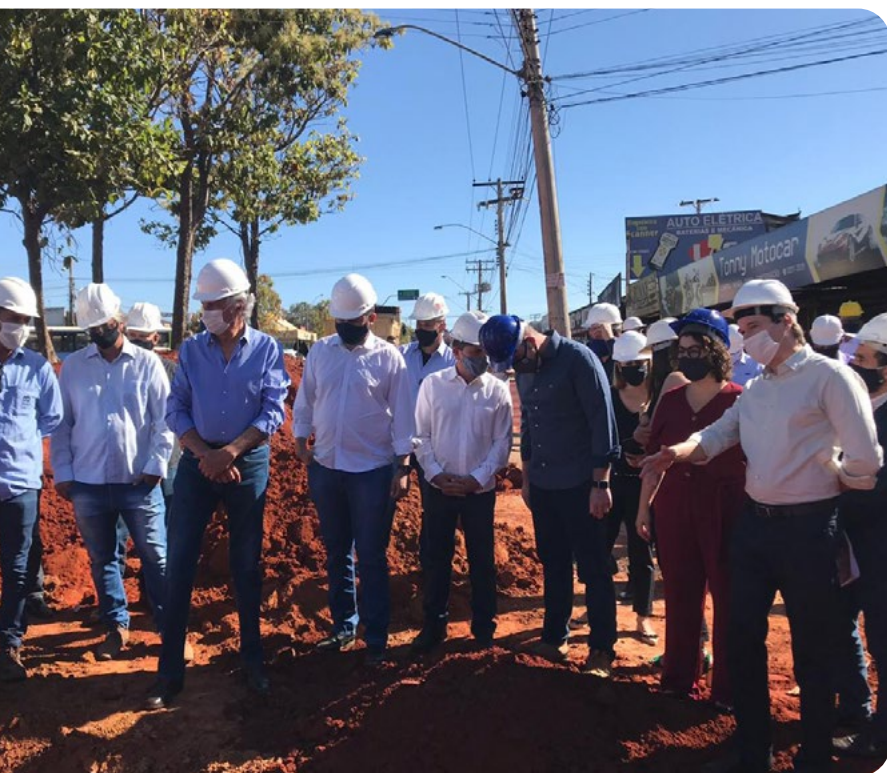
ETA Compacta de Uruaçu
