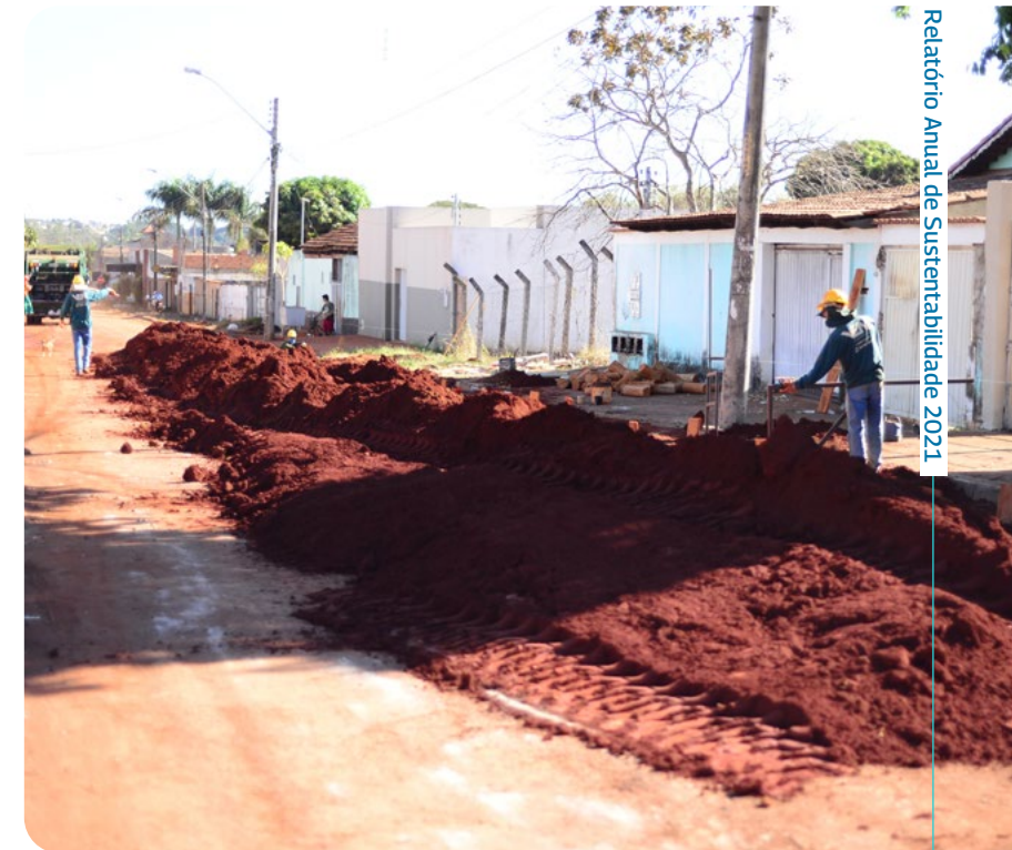
Ampliação do Sistema de Esgotamento Sanitário de Goiânia
