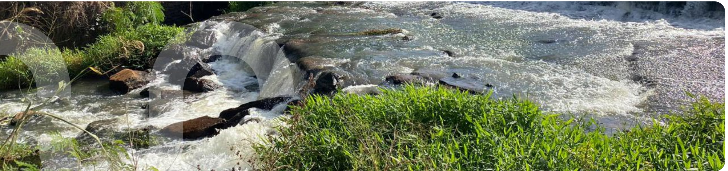
Barragem Fazenda Água Branca
