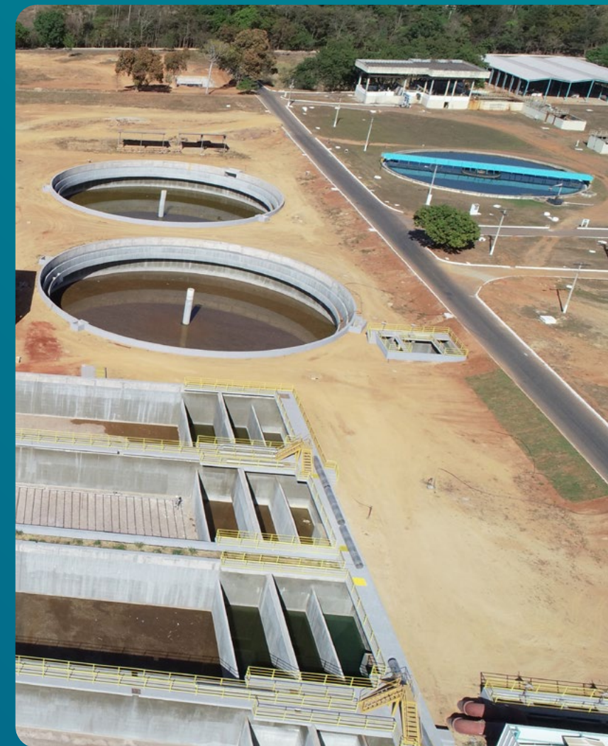
Obras ETE Goiânia - Acervo Saneago
